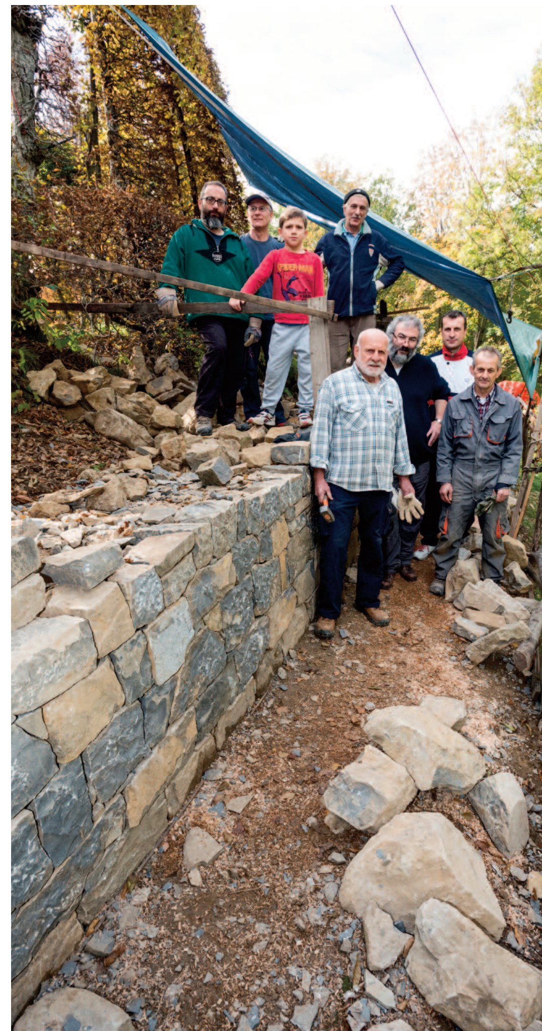
Cantiere a Montenars (ottobre-novembre 2016)
