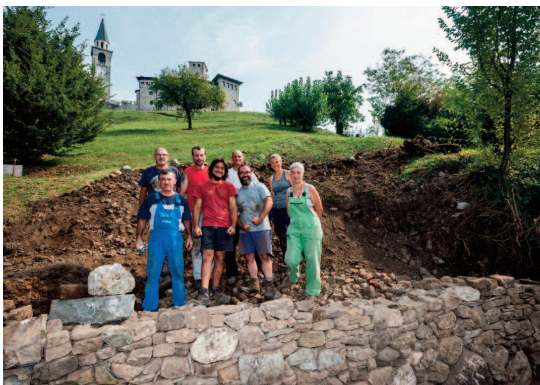
Cantiere ad Arterga (settembre 2016)
