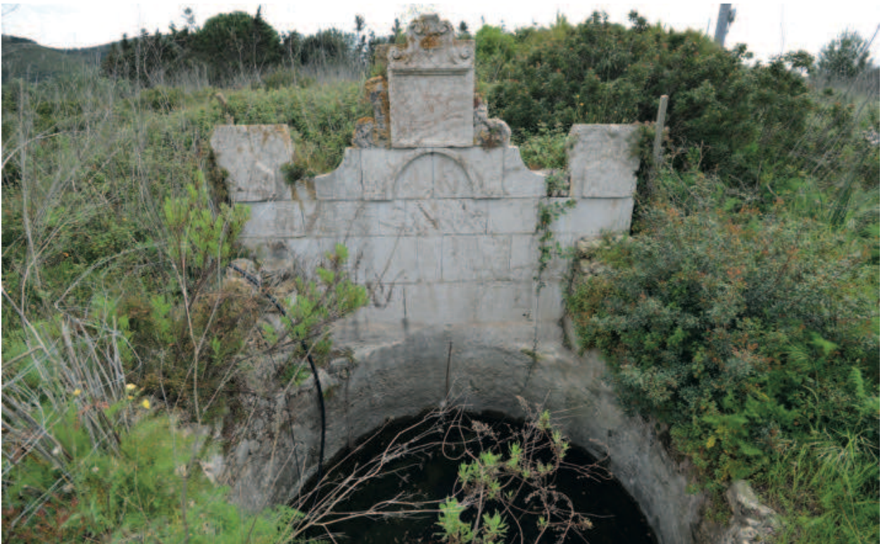
88. Porto Conte, Alghero, pozzo e fontana ricostruita nel 1756 da Tommaso Guibert, comandante della flotta sabauda di stanza sul golfo, per l'approvvigionamento idrico delle navi. La fonte, ricordata dal Cinquecento, recupera due volute quali sostegni dell'epigrafe dedicatoria (foto M.C.).
