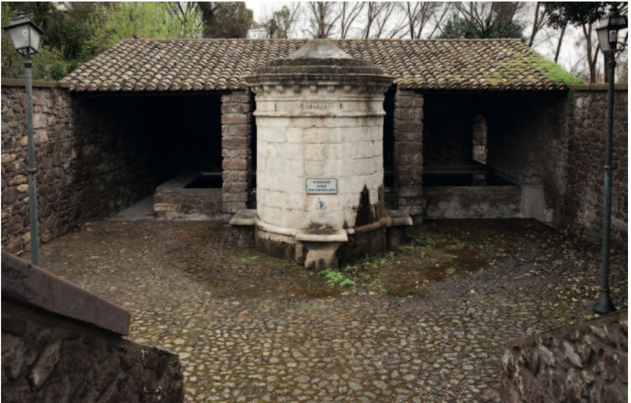
276. Bulzi, Funtana Manna. Costruita nel 1865 è parte di un complesso incluso in un recinto accessibile da una scalinata dove sono collocati un serbatoio fontana cilindrico dal disegno neoclassico, un lavatoio e dei bagni pubblici e all'esterno un abbeveratoio (foto Stefano Ferrando).
