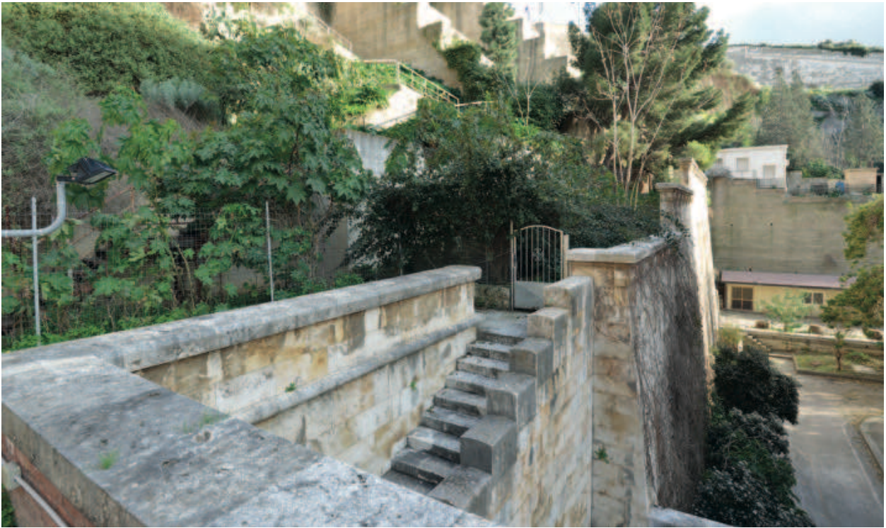
177. La rupe sulla Fossa di San Guglielmo e la fontana del Novecento. Sullo sfondo a destra i bastioni del Castello di Cagliari, a sinistra i gradoni di sostegno in cemento (foto M.C.).
