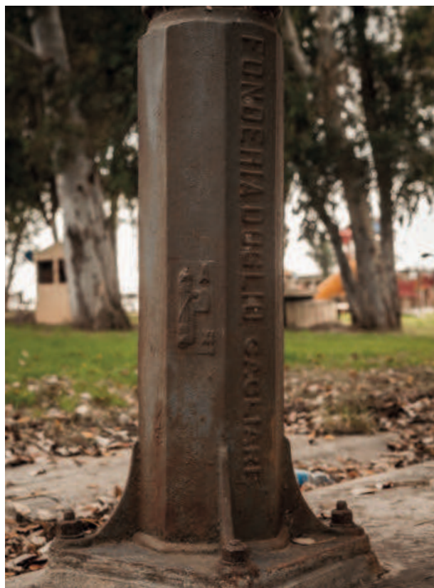
273. A lato. Particolare del piede di uno dei pilastri in ghisa prodotto dalla Fonderia Doglio di Cagliari e databile al 1932-33 grazie alla scritta "A XI" e al simbolo del fascio.
