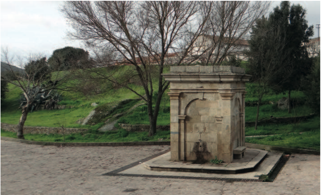
40. Oschiri, fontana e pozzo de Pischinas. Struttura a pianta centrale con quattro archi ciechi sui prospetti, secondo forme neoclassiche, realizzata in conci regolari di granito (foto Stefano Mais).
