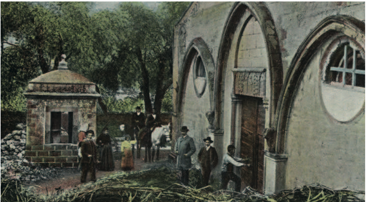
41. Bosa, pozzo coperto un tempo esistente al lato della cattedrale di San Pietro Extramuros, nella foto a sinistra. La chiesa di epoca giudicale (1073) ha un prospetto rinnovato secondo forme cistercensi (Materiale tratto da www.sardegna.digitalibrary.it , Id: 31724).
