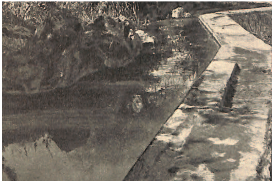
63. Villamassargia, muro di captazione e trasporto delle acque della sorgente di Cabud'Acquas (da Le sorgenti italiane ).
