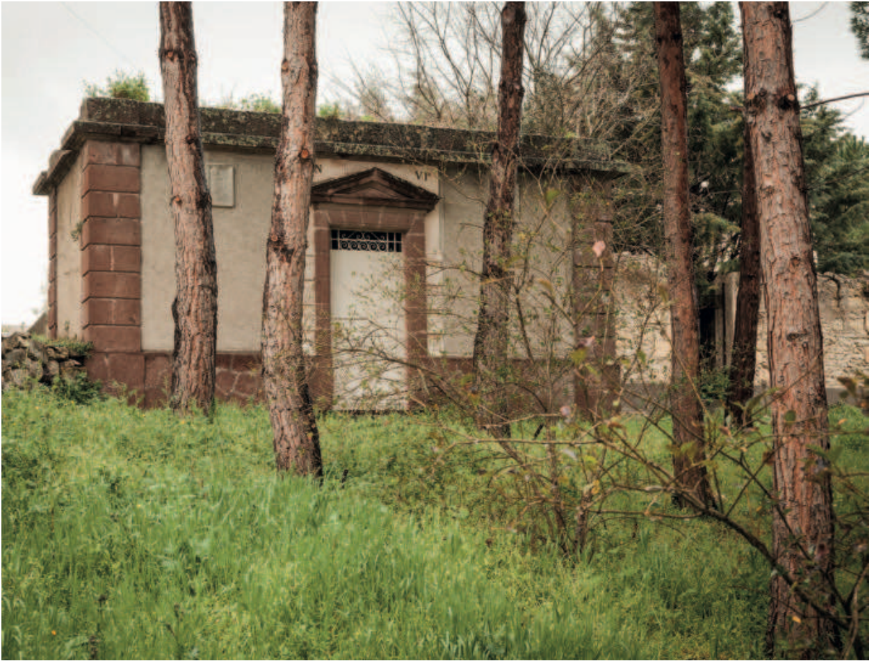
263. Serbatoio dell'acquedotto di Martis (foto Stefano Ferrando).
