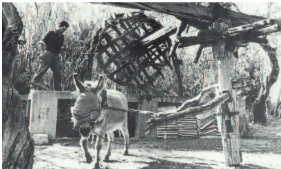
17. Quartu, noria a tazze in un'area ortiva. Meccanismi a ruota per il sollevamento delle acque da pozzi, tramite ruote azionate da animali sono documentate dal Cinquecento in Sardegna, secondo una lunga tradizione mediterranea. Il cavallo o l'asino, bendati, muovono un albero verticale che trasmette il movimento ad un altro orizzontale, quindi ad una ruota cui sono collegati vasi uniti da corde che attingono in profondità.
