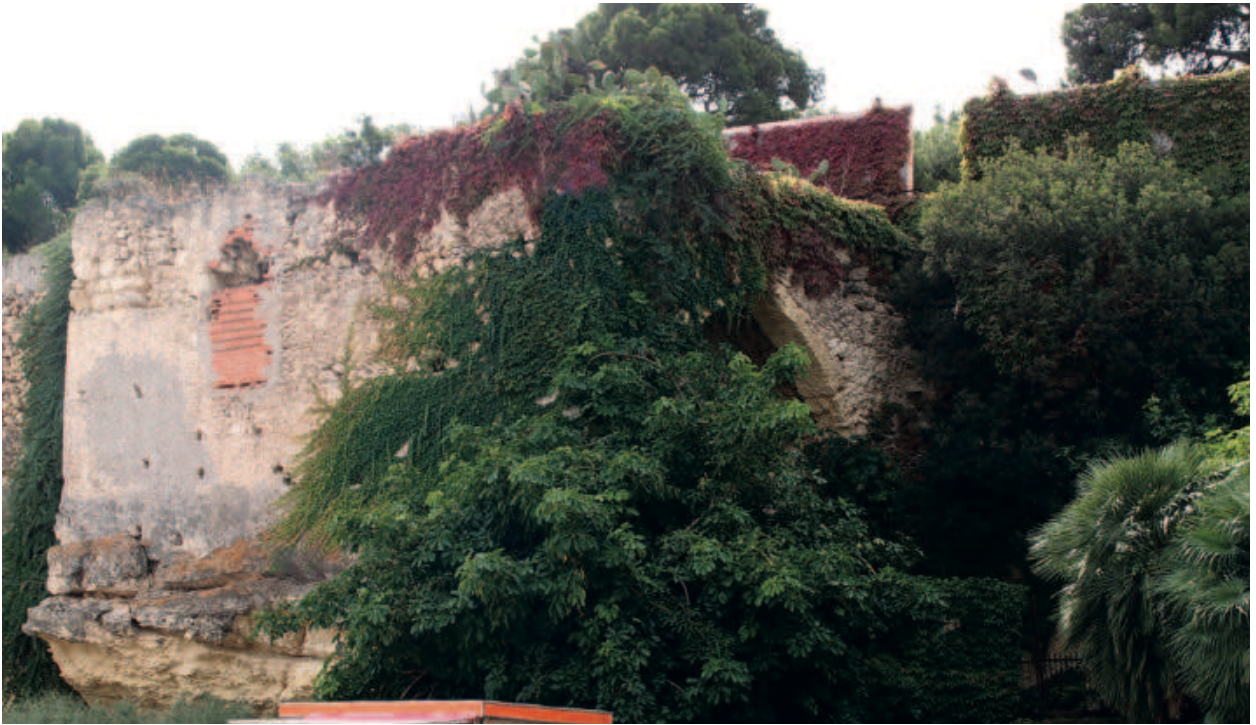
181. Veduta del grande edificio cisterna alle spalle dell'arco di prospetto del pozzo-fontana tardo medievale in località Sa Duchessa, Cagliari (Foto M.C.).
