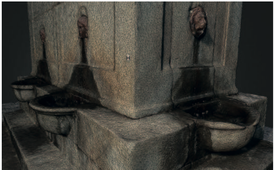
193. Reticolo di rilievo fotogrammetrico per il modello ricostruttivo dello stato attuale della fontana di Su Cantaru Mannu, Paulilatino (Gianni Alvito, Teravista, Cagliari).
