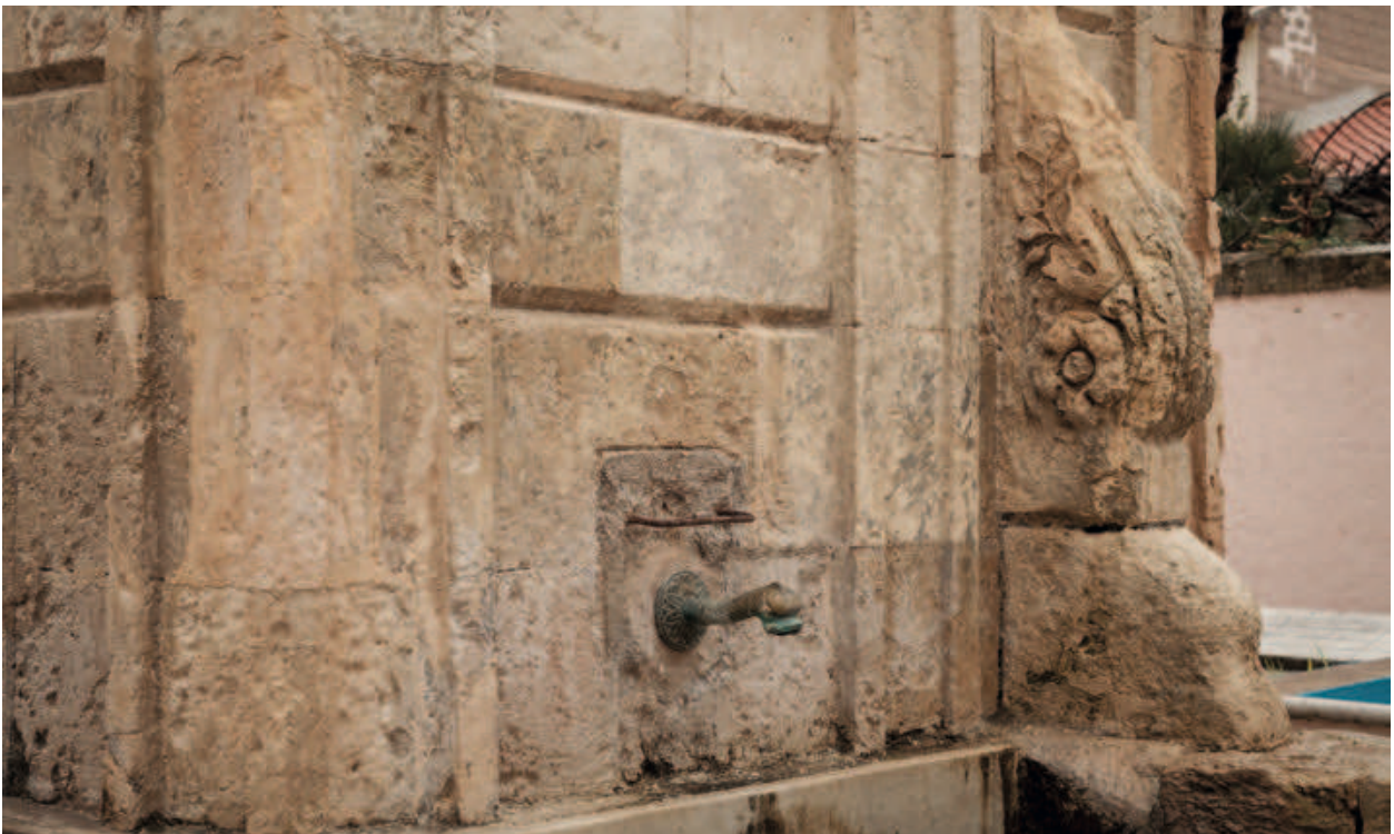
48 e 49. Il lavatoio e la Fontana Rosa di Nulvi nella sistemazione ottocentesca, disegnata nel 1886 da Eugenio Serra, insieme ad uno spazio urbano di relazione. Una voluta con decorazione vegetale e alcuni conci sul lato conservano la memoria di una precedente architettura. La fontana è stata recentemente recuperata dall'amministrazione comunale (foto Stefano Ferrando).
