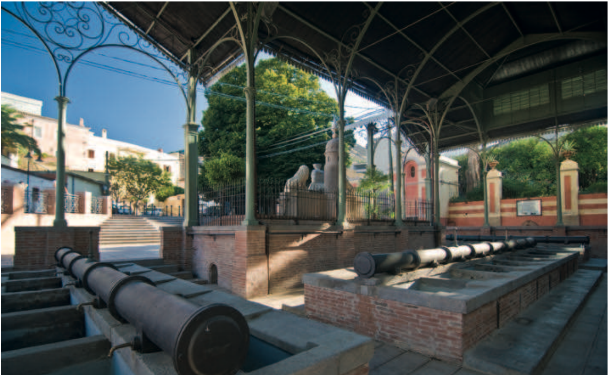
247 e 248. Lavatoio e fontana pubblica di Villacidro, progetto di Enrico Pani del 1894 (Foto Alessandro Cani, da MAIS, Le architetture dell'acqua di Enrico Pani , cit., pp. 259-260).
