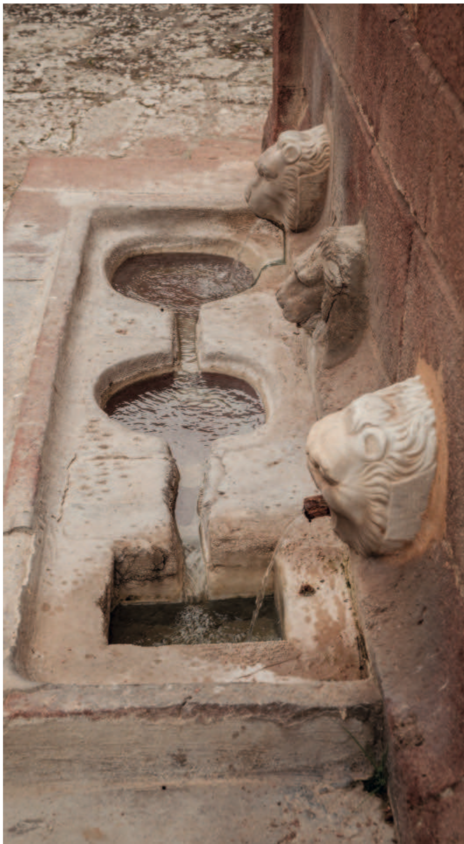
93. Banari, Funtana de Josso. Leoni versatori e vasche di raccolta, due circolari e una quadrata ricavate in un unico blocco di trachite rossa (foto Stefano Ferrando).
