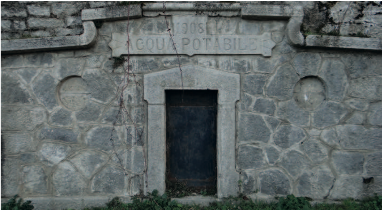
260. Serbatoio dell'acquedotto di Bantine, frazione di Pattada (foto Stefano Mais).
