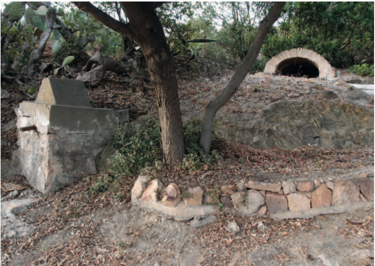
19. San'Anna Arresi, via della Vecchia Fonte, presa d'acqua e ingresso ad arco al corridoio coperto a botte che comunica con una cisterna ipogeica su una sorgente, singolarmente simile alla stampa in alto.
