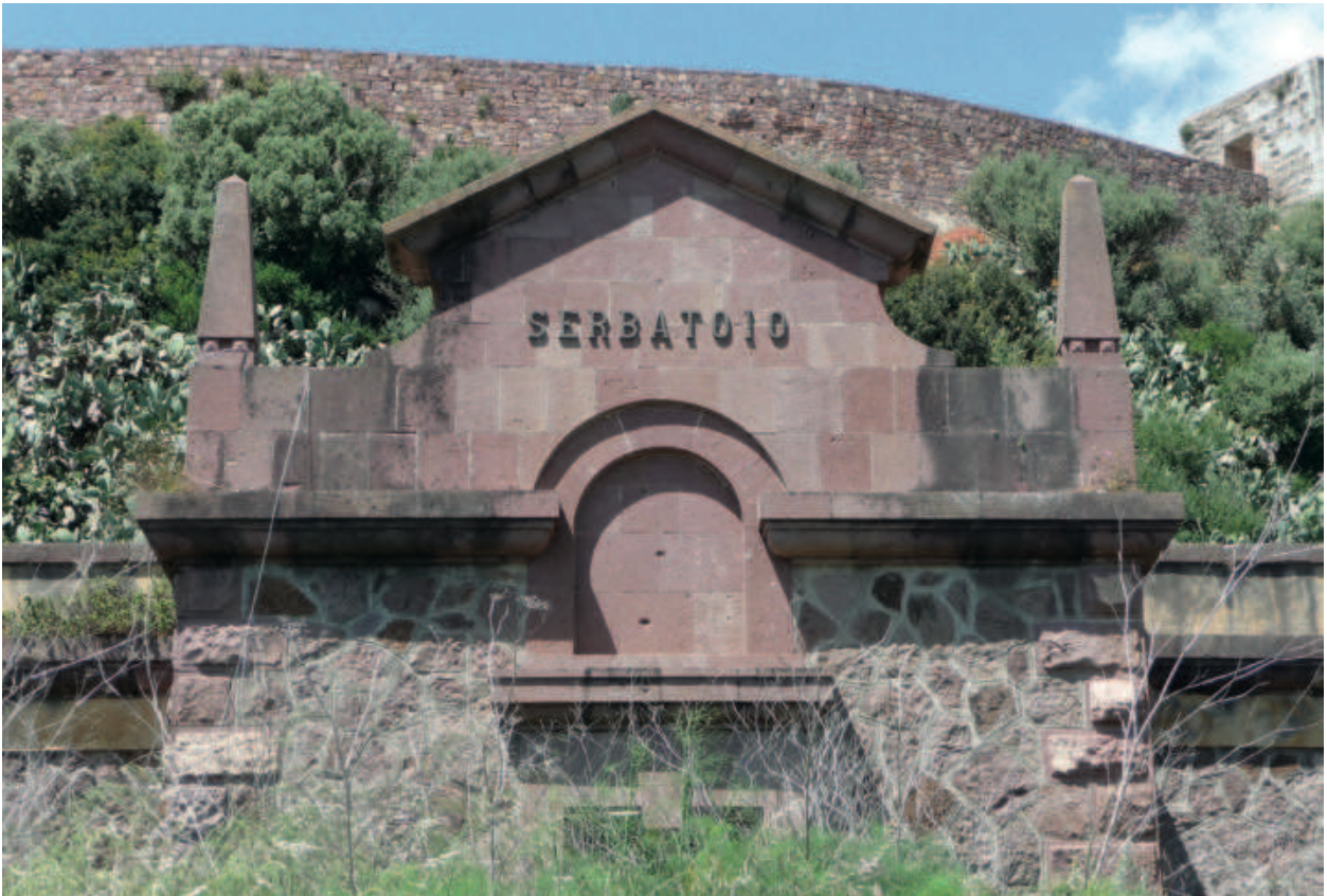
259. Serbatoio dell'acquedotto di Bosa, 1868-1877 (foto M.C.).
